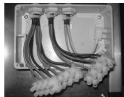
Индивидуальный клеммник для каждого нагревательного элемента.
